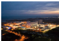
石岛湾高温气冷堆示范工程
