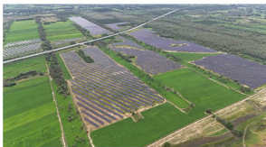
彰武光伏复合治沙示范项目
