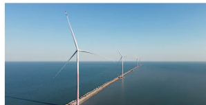
天津港防波堤风电项目
