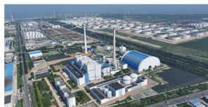
仙人岛热电厂 18 兆瓦分散式风电项目
