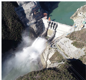
乌弄龙水电站
