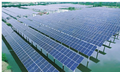
应城市新能源百万千瓦基地项目
