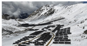
纳古光伏电站一期项目
